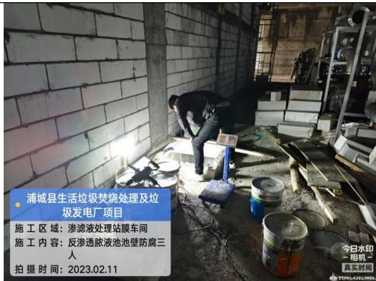
反渗透液池池壁防腐
