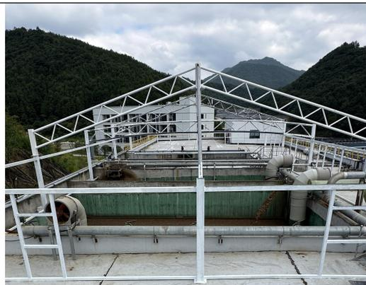
污水处理站（反硝化+硝化）
